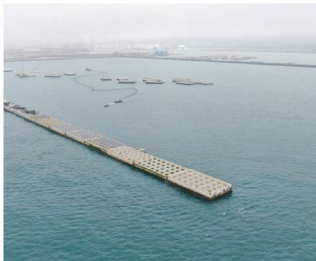
圖二 | 臺北港物流倉儲區第三、四期圍堤新建工程沉箱目前托放現況
