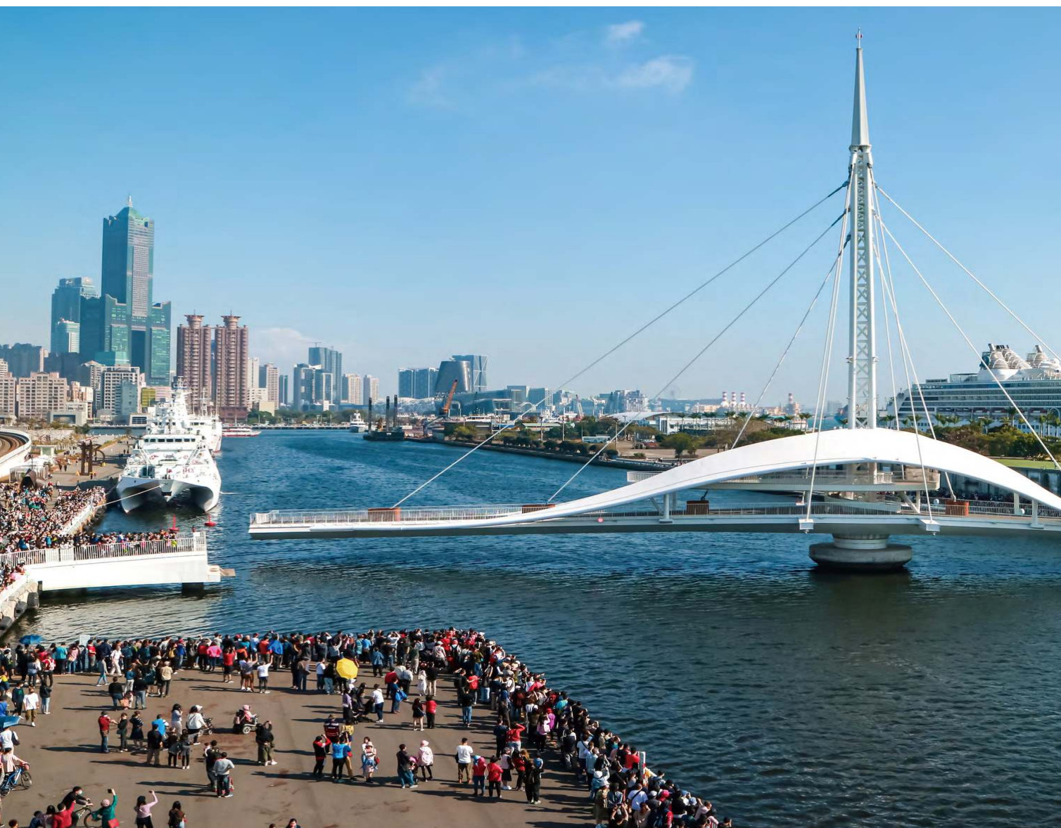
高雄港 大港橋
