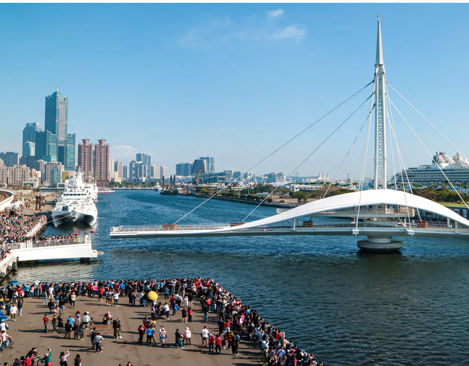
高雄港 大港橋
