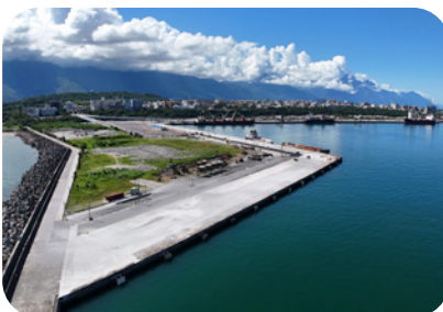
花蓮港震後重建，港埠韌性再升級
