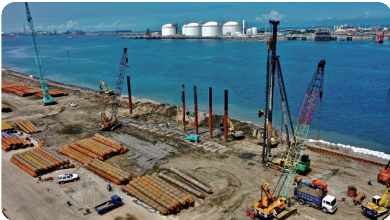
圖 | 臺中港37、38號碼頭施工現況
