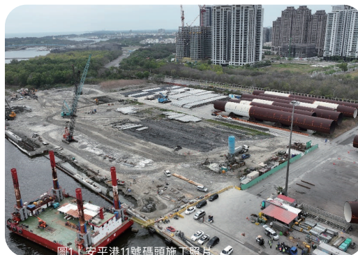
圖1 | 安平港11號碼頭施工照片
