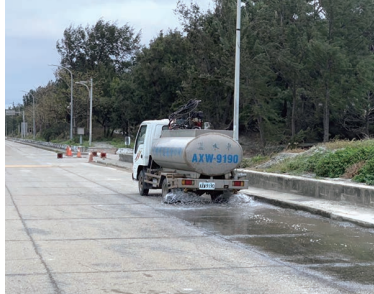
工地周邊道路執行灑水作業 臺中港
