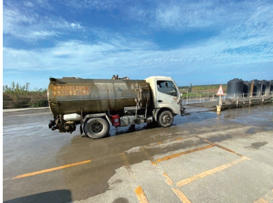
工地周邊道路執行灑水作業 臺北港
