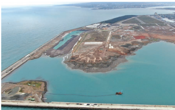
臺北港物流倉儲區
