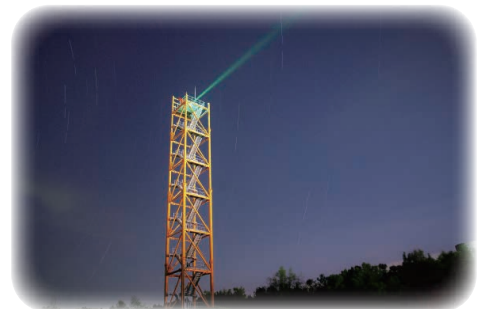
改建後第五組後導標(梧棲觀光漁港北側)夜景
